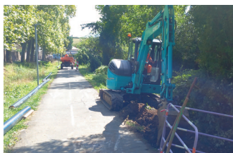
3 chantiers pour améliorer le réseau d'eau potable
