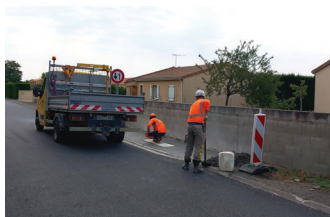
Reprise de la voirie chemin des Meuniers
